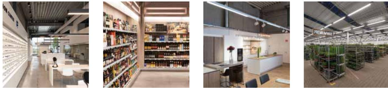
Gerade für die Warenpräsentation in Sortimentsgängen ist ein Lichtband erste Wahl. Einfach und doppelt asymmetrische LIPA LINEDO Linien sorgen für eine gleichmäßige Ausleuchtung der Regale. Stromschienen- und Strahlermodule bieten in der Obst- und Gemüseabteilung und bei Aktionsware vielfältige Möglichkeiten der Inszenierung.
